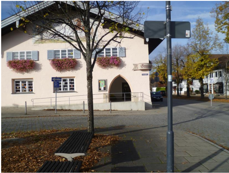
Gemeindebücherei Lenggries, ehemaliges Postgebäude
